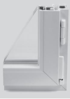
По теплоизоляции новый профиль REHAU сопоставим с толстой кирпичной стеной: он оснащен сразу шестью воздушными камерами. Глубина 80 миллиметров позволяет установить широкие стеклопакеты последнего поколения. Система обеспечивает в помещении показатель шума не более 30 дБ. Благодаря этому профиль подходит и для городских квартир с панорамными окнами, и для загородной недвижимости.
